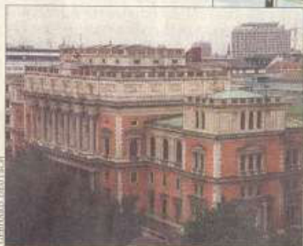
Börse: Historische Fassade
